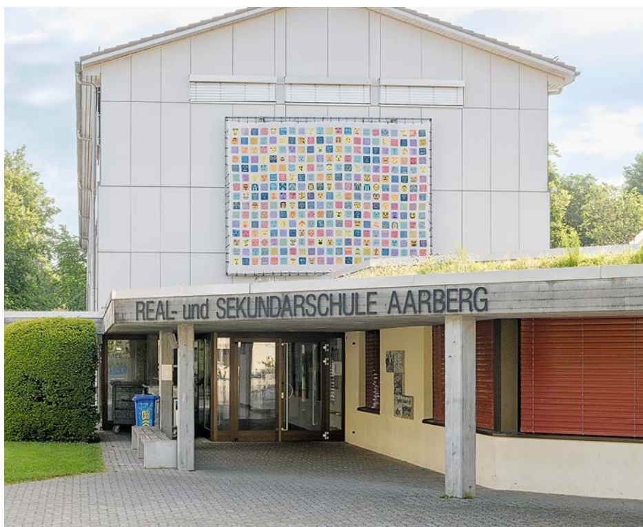
Real- und Sekundarschule Aarberg: Installierte CO 2 -Messgeräte in Klassenzimmern
